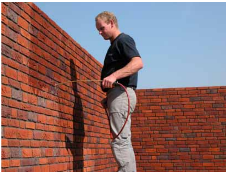
Figuur 2 – Impregneren met een hydrofobeermiddel d.m.v. airless spray.
